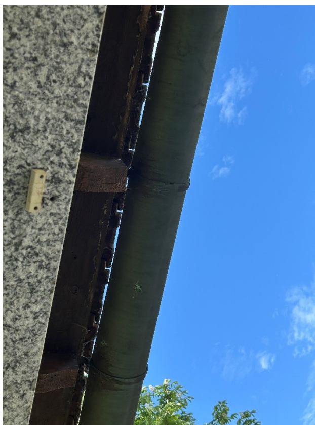
Foto n. 15 – Canali e tegole non posati a perfetta regola d’arte
