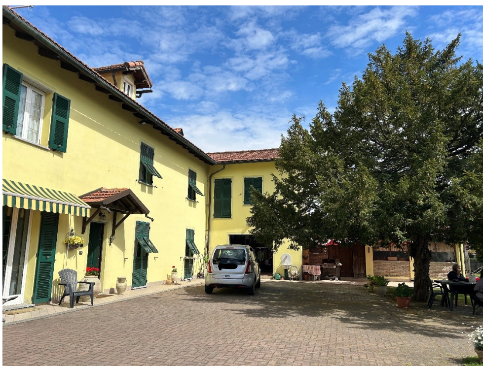
Foto n. 2 – Prospetti verso cortile interno
